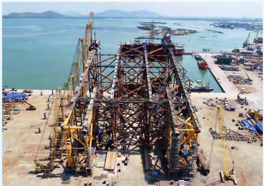
Sử dụng 8 cầu để lắp dựng Panel Row 8 - Chân đế Sao Vàng.
